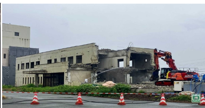
管理棟 躯体解体状況
