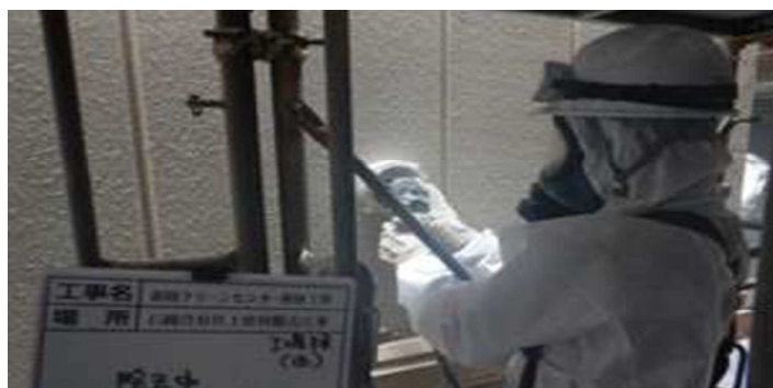
工場棟 外壁アスベスト除去状況
